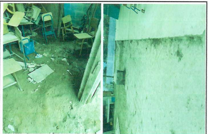
Foto 4: en un alula no hay piso o torta de cemento así como en una parte del patio, por lo que es necesaria la fundición de torta de cemento.
