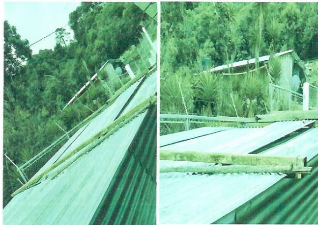
Foto1: En un aula se necesita cambiar las láminas que estan en mal estado y mal aseguradas.
